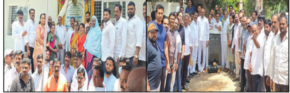
అలాగే గచ్చిపాటి డివిజన్ సబ్ గ్రాండ్లో రూ.30 లక్షల అంచనా వ్యయంతో చేపట్టనున్న మండల మంచినీటి పైప్లైన్ నిర్మాణ పనులకు అరెకపూడి గాంధీ శంకస్థాపన చేశారు. నియోజకవర్గంలో తాగునీటి సమస్యకు శాశ్వత పరిష్కారంగా
